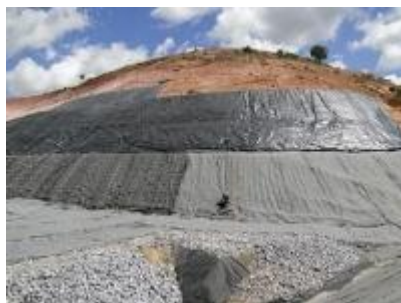
Aterro sanitário de Maceió, localizado no Benedito Bentes, já funciona
